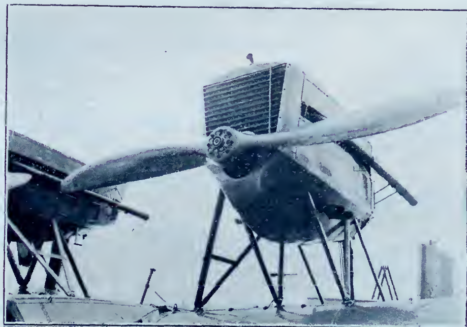
Fig. 8. - Piazzamento dei motori sopra l'ala
